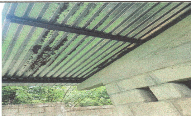
Foto 1: Cambio de láminas por deterioro.
