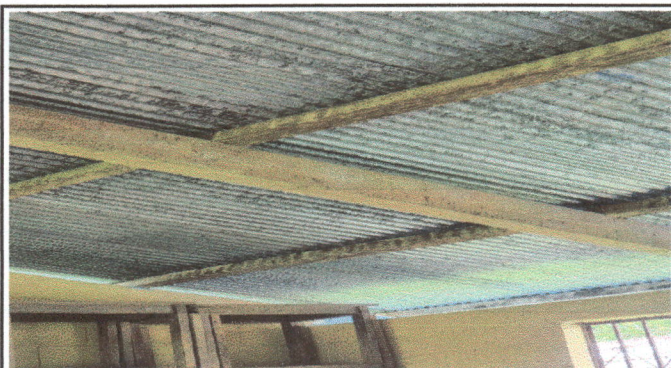
Foto 3: Cambio de costanera.
