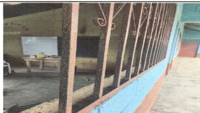
Foto 4: Mantenimiento de balcon.
